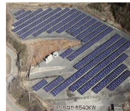
雨川エコエネ太陽光設置工事(H27.6)
