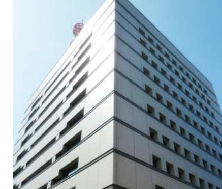
警視庁新橋庁舎防犯設備改修工事 (H27.3)
