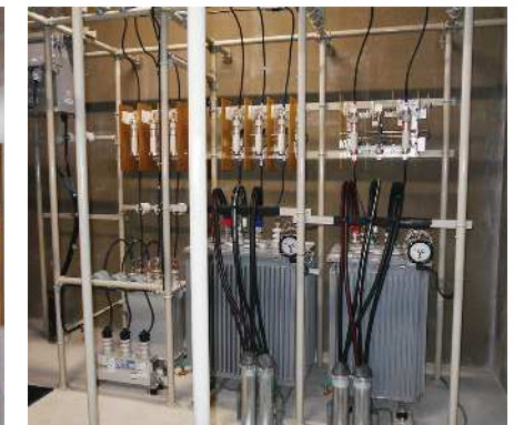
江東区立東陽中学校受変電設備その他改修工事(H26.8)
